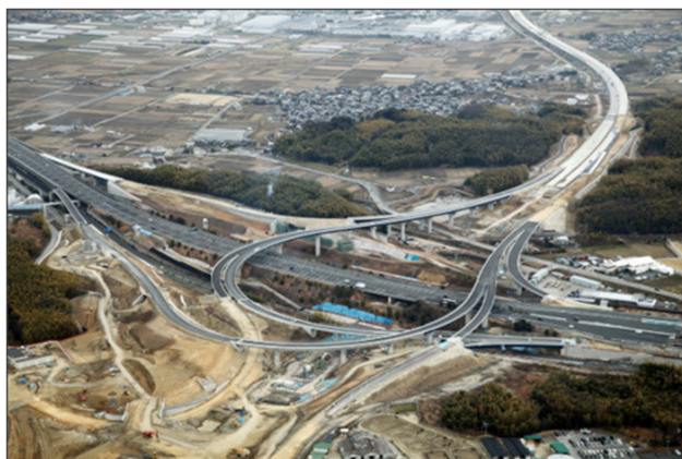
建設中の新名神・城陽ジャンクション
