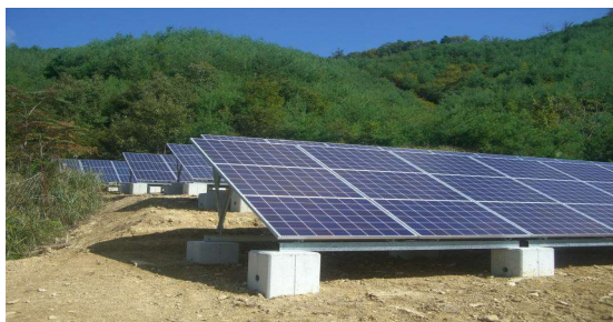
この11月から発電開始の第7発電所
